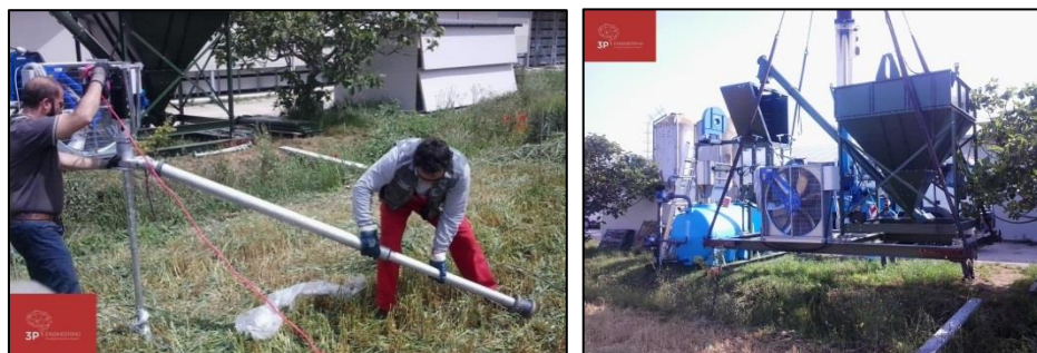
Figura 2 – Fasi di installazione dei prototipi (foto: progetto LIFE CHIMERA)
