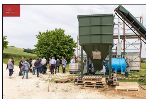
Figura 12 – Visita agli impianti CHIMERA (foto: Luca Bellagamba)
