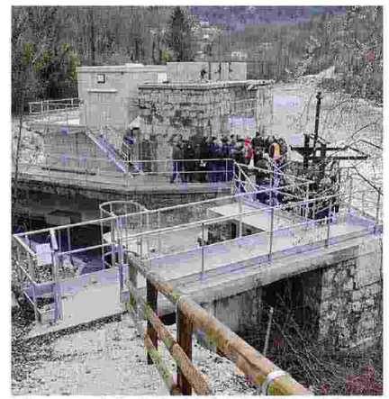
Qui sopra una centralina, in altostatori a Cortina (Foto Bandion)
